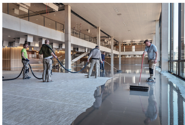
Přestěrkování UZIN RR 201 stěrkováci hmotou UZIN NC 170 LevelStar pomocí čerpací techniky.
