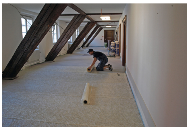
Plošné uložení rohože UZIN RR 201 na podklad, který je sanován.
